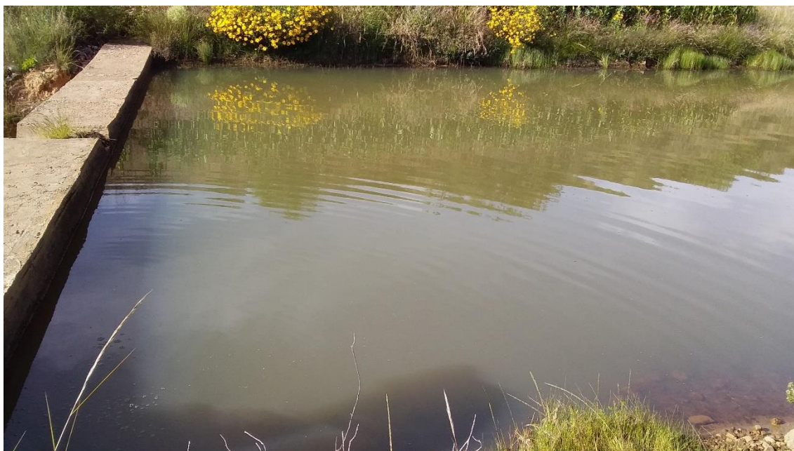
La pequeña represa que alimentará a los tanques en tiempo de escasez de agua
